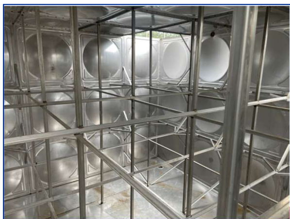
Hệ giằng bên trong bồn/ Internal bracing system of the tank
