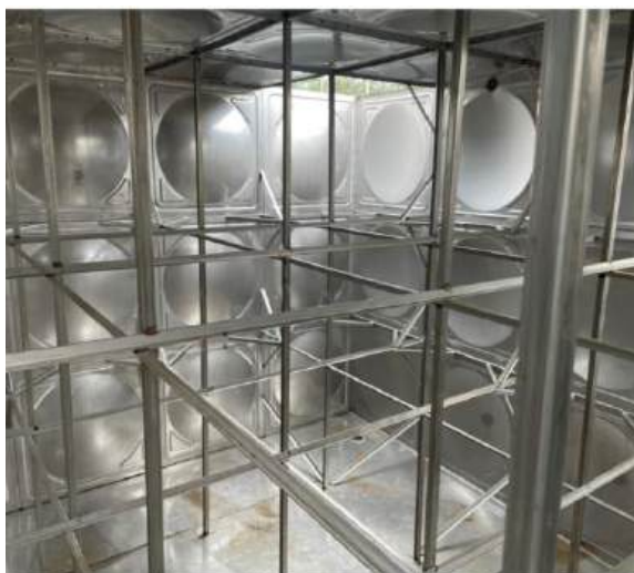
Hệ giằng bên trong bồn / Internal Bracing System
